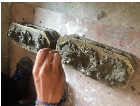
ก.กระทุ้งมอร์ต้าร์ด้วยแท่งเหล็ก
